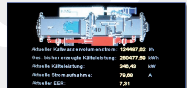
Ansicht der Leistungsdaten
