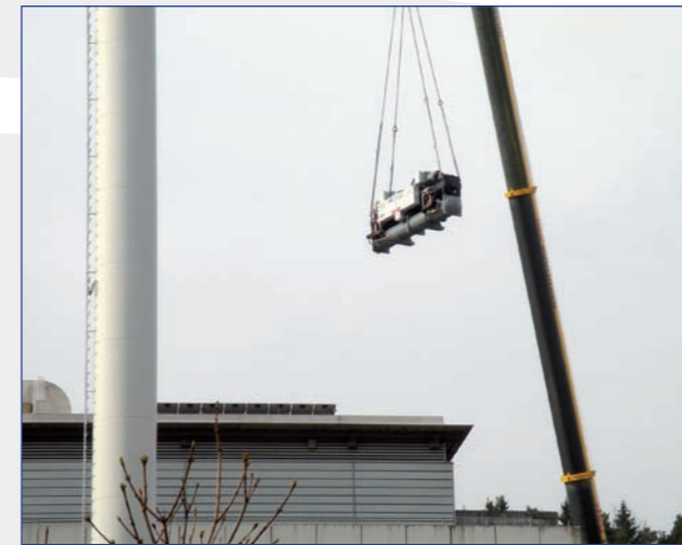
Einbringung einer der 30XW Aquaforce mit Hilfe eines Krans ...
