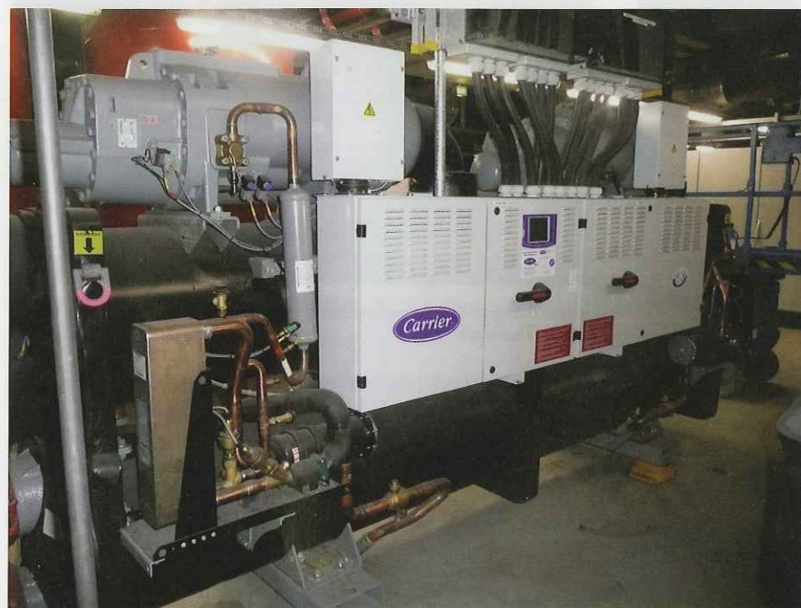
AquaForce-Maschinen sind mit Schraubenverdichtern der neuesten Generation ausgestattet und haben die Energieeffizienzklasse A Bild: Carrier
