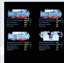
Gesamtansicht der Leistungsdaten der Kältezentrale
